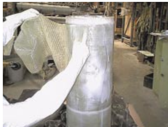
Demostración de aplicación de fibra de vidrio en columna circular.
