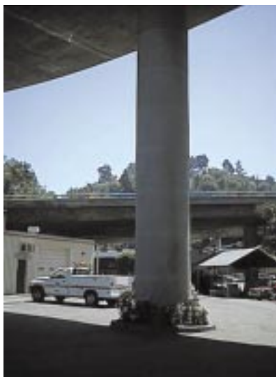
Recuperación columna con fibra de vidrio en autopista en Los Angeles, California.
