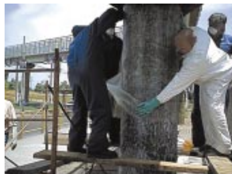
Recuperación columna con fibra de vidrio en autopista en Los Angeles, California.
